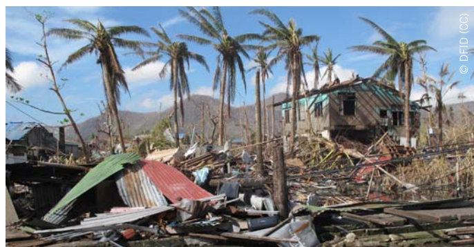
Zerstörung durch Wirbelsturm Haiyan auf den Philippinen
